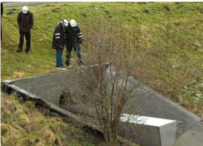
Abwasserfilterung vor dem Ableiten in das Abwassersystem
