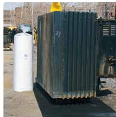
*Kann unter undichten Transformatoren verwendet werden.*
